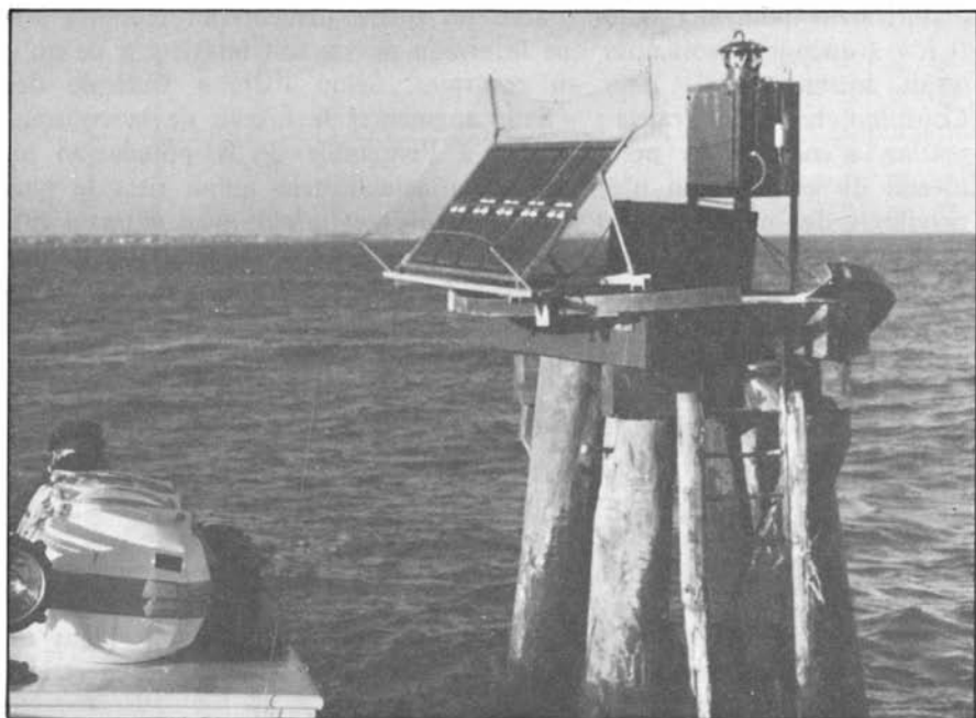
Balise lumineuse alimentée par générateur solaire.
