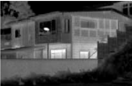
Thermographie infrarouge d'un bâtiment : diagnostic et identification
